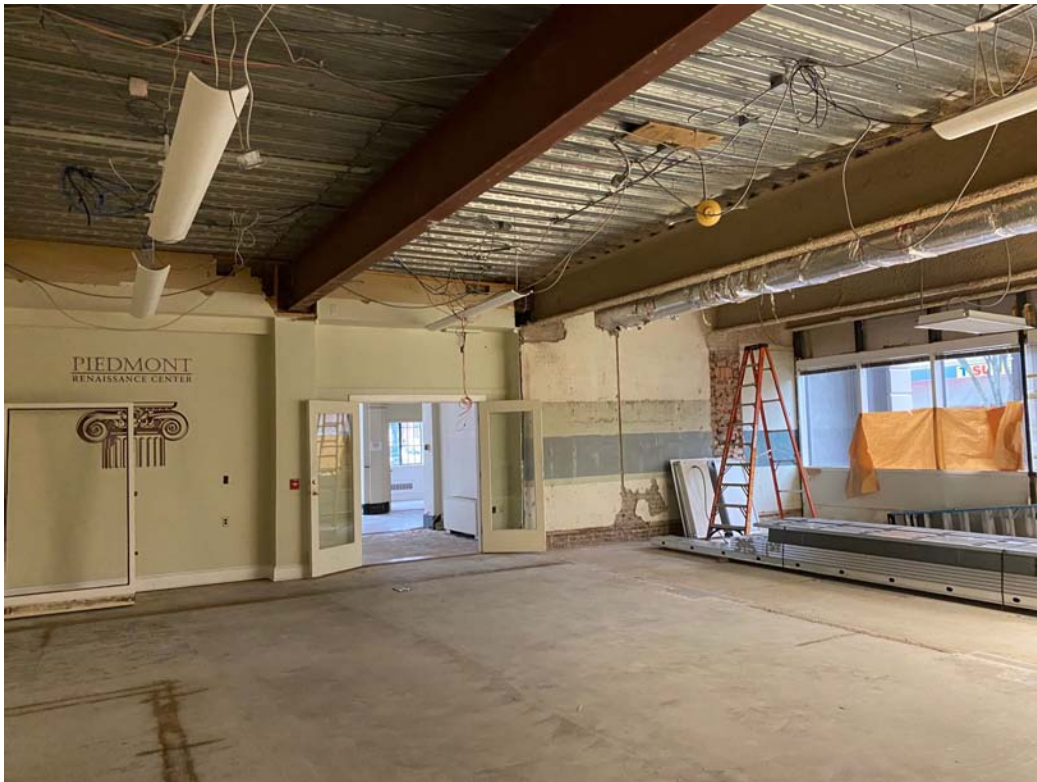
Tenant space interior - (51-53 Union Street S.)
